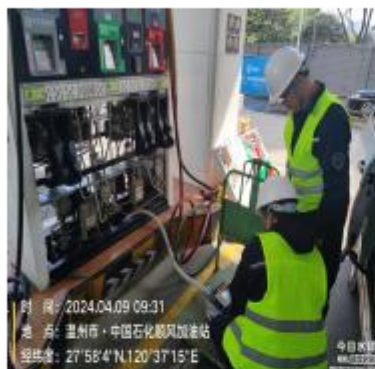
现场检测照片
