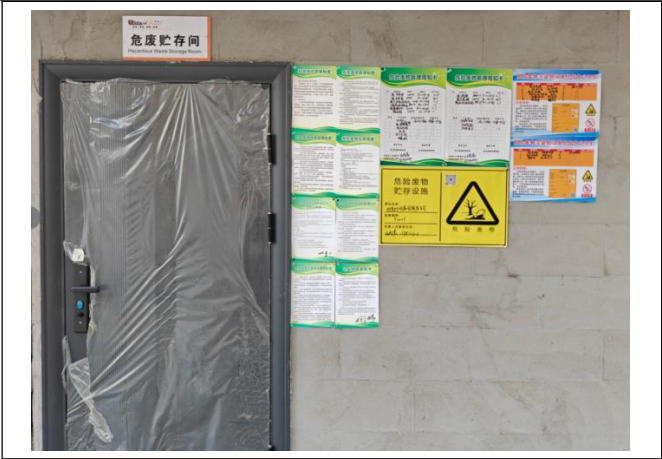
图3-1 危废暂存间图片
